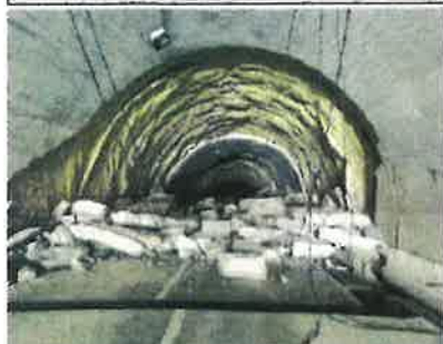
国道249号大谷トンネル（珠州市）
