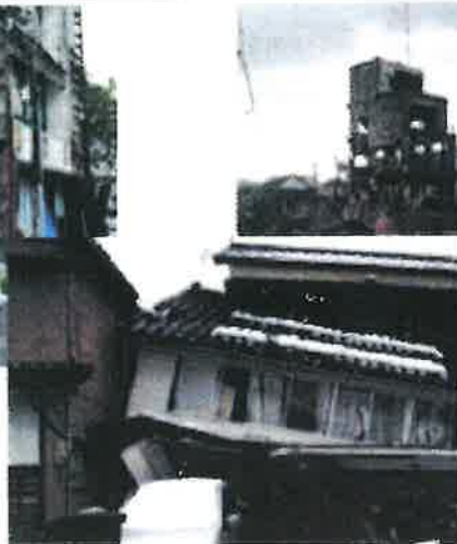
木造建築物の倒壊状況（六水町）
