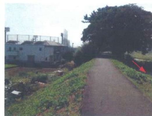
右岸堤防状況
