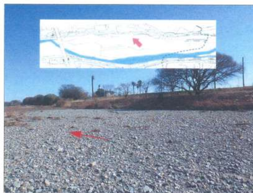
河川内より右岸を望む
